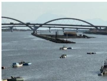
舟運の妨げとなる土砂の堆積を防ぎ、航路を確保するため、明治23年(1890)、オランダ人技師ヨハネス・デ・レーケの設計により作られたといわれています。全長は約6kmあり、今もなお、自然の川の流れだけで水深を維持できるようになっています。
